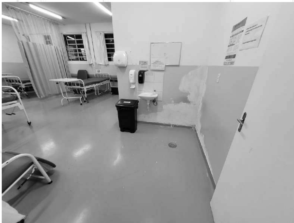
FOTO 8. Vista para a limpeza, aplicação de massa corrida, e lixamento.
